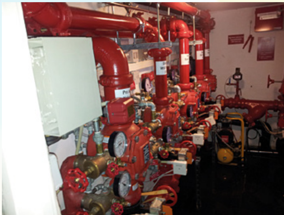
Kompakte ventiler ble brukt til å løse problemet med plassbegrensninger i kirkens lille maskinrom.
