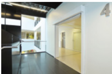
Branngardiner gjør det mulig å ha åpne passasjer.
