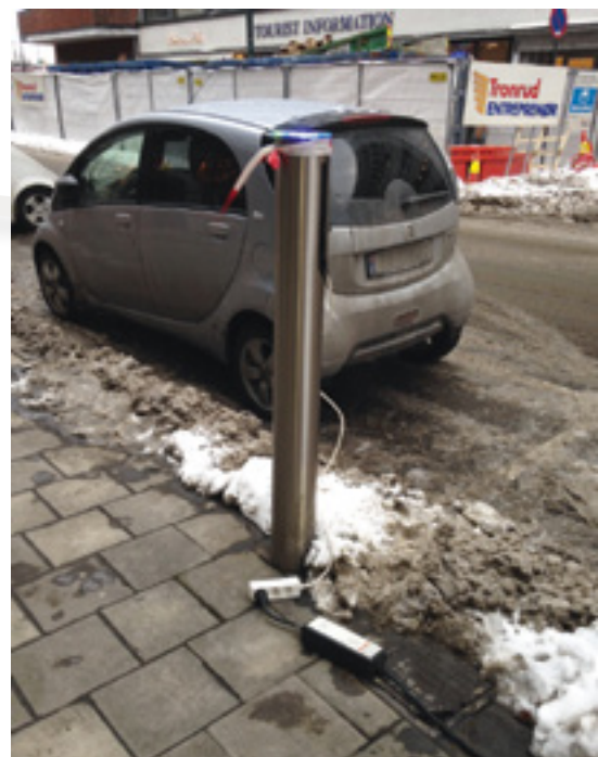
Foto: Schneider Electric.
